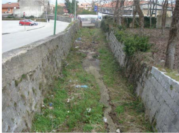
Foto k – tratto di pianura del torrente Conca nel centro urbano di Cervinara (AV); si noti l'opera di attraversamento a valle del tronco in esame
