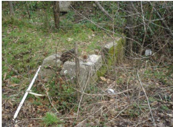
Foto I – briglia completamente coperta da vegetazione lungo il torrente Conca
